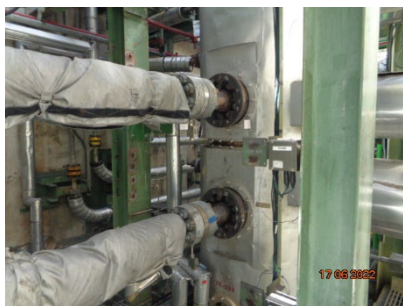
ภาพที่ 2-33 Rupture Disc PSF บริเวณ Vent Stack
