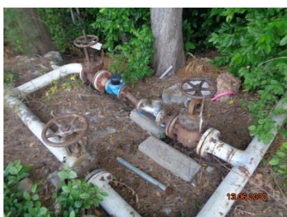
ภาพที่ 2-19 ท่อน้ำเสียที่ส่งไปบำบัดที่ PTT GC
