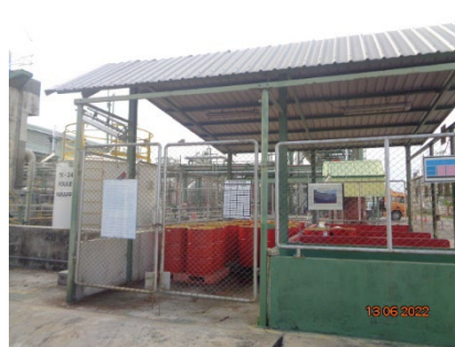
ภาพที่ 2-10 บริเวณที่รวบรวม Low Polymer ที่มีคั่นคอนกรีตล้อมรอบ
